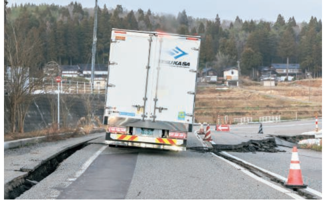
陥没、亀裂等による悪路の中、被災地へ物資輸送を行うトラック。
