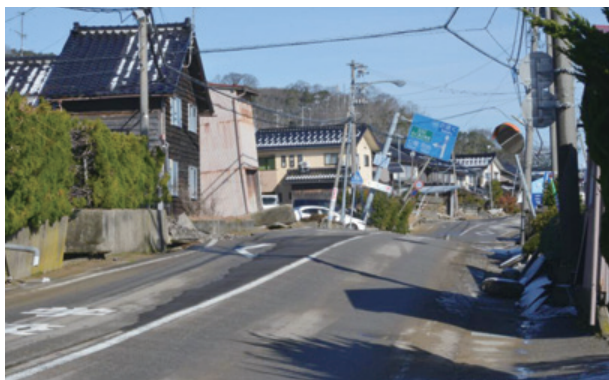
出所) 石川県HP 「令和6年能登半島地震 写真でみる被害状況」
