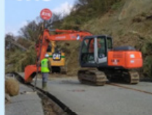
国道249号緊急復旧作業状況
