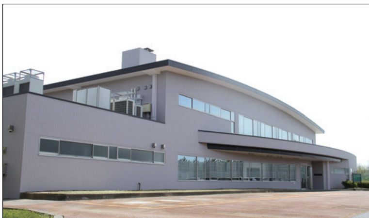
石川県トラック会館(建築面積 1,178㎡)
