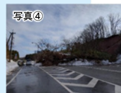
片側交互通行により普通車通行可
