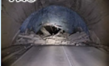
国道249号中屋トンネル崩落状況
