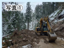
県道38号緊急復旧作業状況
